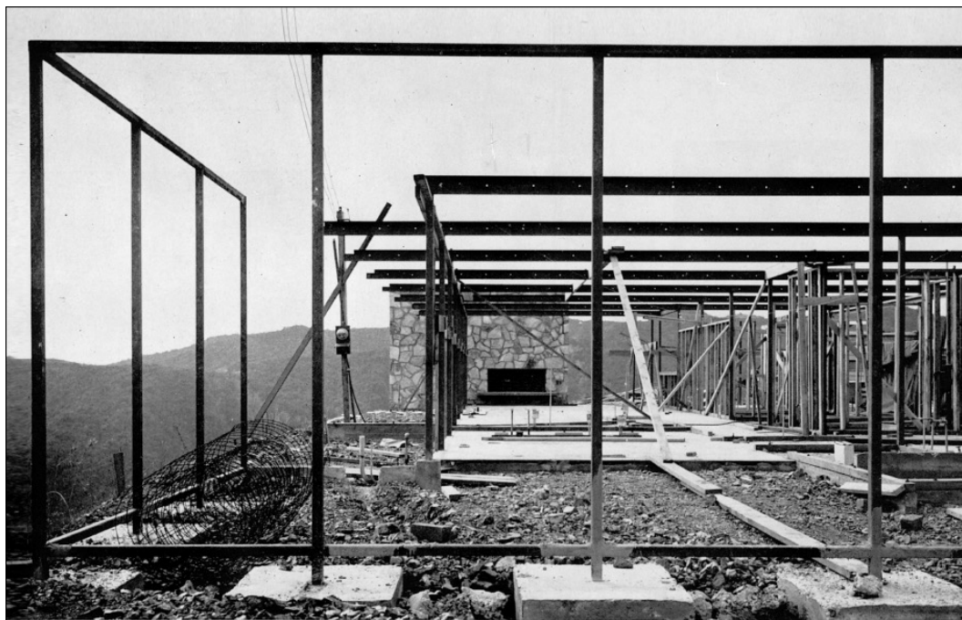
Figura 4. Montaje de estructura.
