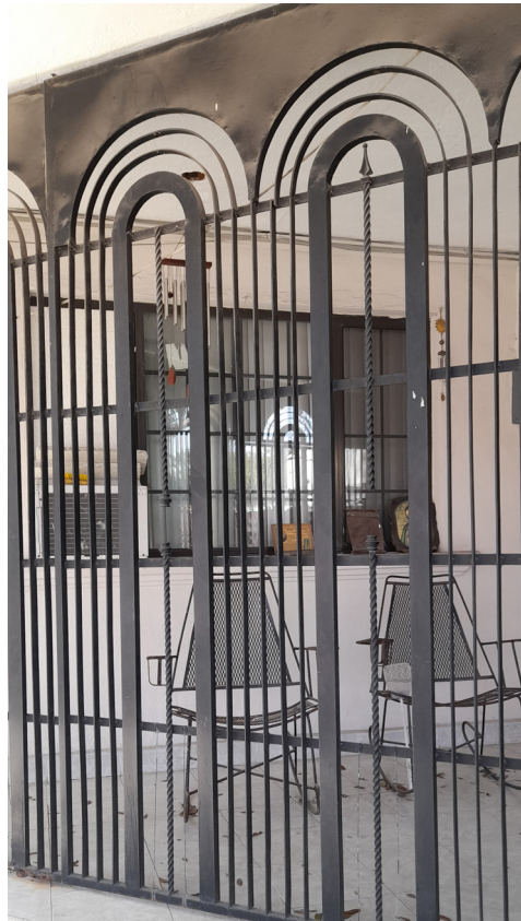
Figura 7. Reja metálica del porche de Don Ricardo.
