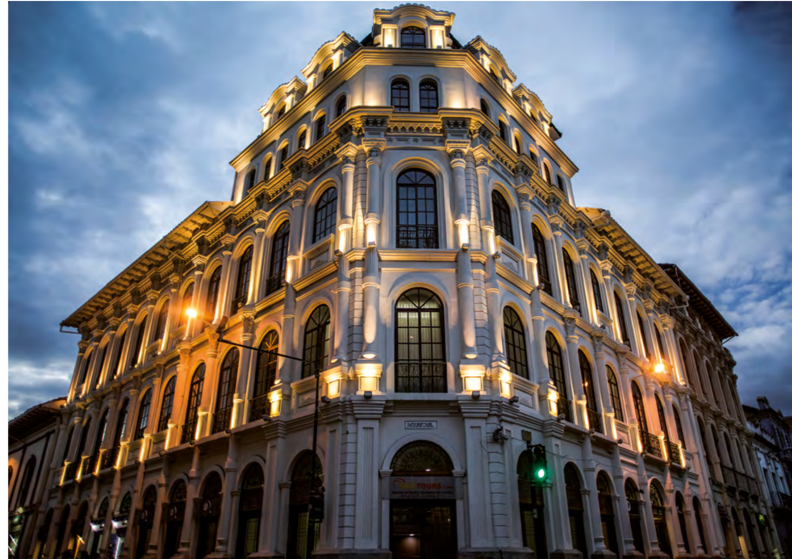
Antiguo Hotel Patria, calles Gran Colombia y Luis Cordero, construcción de 1924. Foto: Juan Carlos Astudillo
